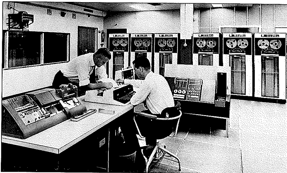
"Vårt företags dyraste skrivmaskin. Den lämnar meddelanden om arbetsoperationens gång och är på bilden det gemensamma intresset för Olle Olsson och (sittande) Gunnar Karlsson. I förgrunden en hålkortsläsare avsedd för inläsning av programmet." Ur "Luftrenaren" 1961.
