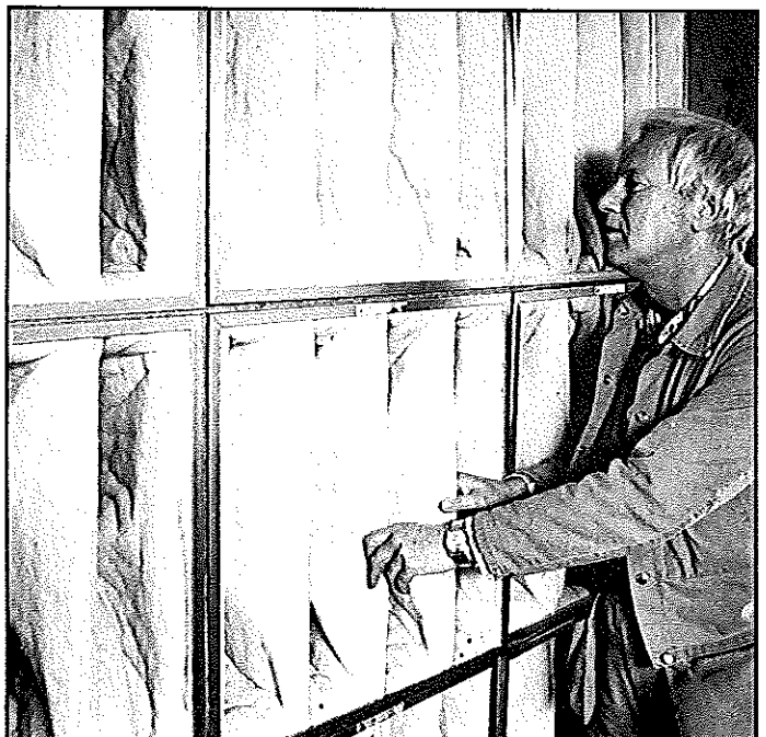
85-90% av alla partiklar i luften filtreras bort, eventuella dofter passerar. Det är bara operationssalarna som har renare luft. De jättelika bfiltrarna byts två gånger per år.
