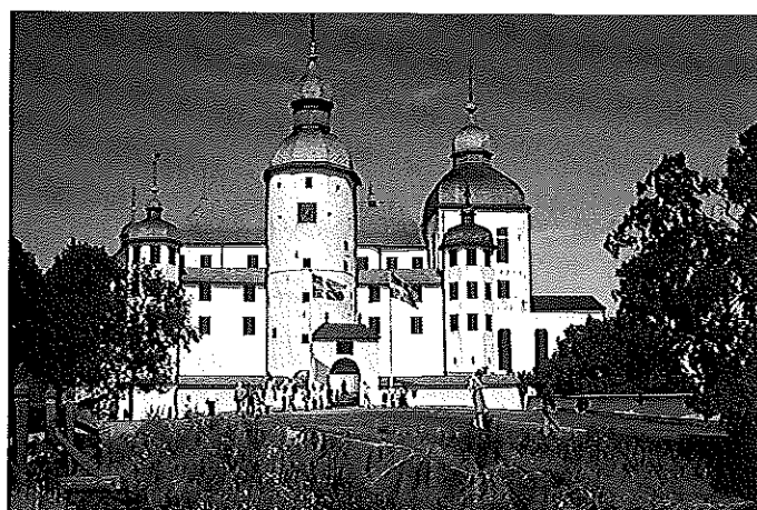
Läckö slott vid Lidköping
